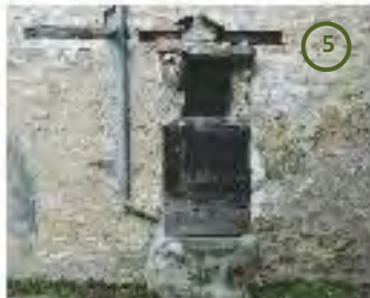
Puits de l'impasse des Carneaux
