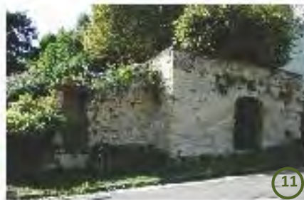
puits rue de l'Eglise
