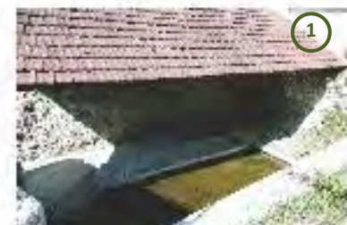
lavoir rue de Puiseux
